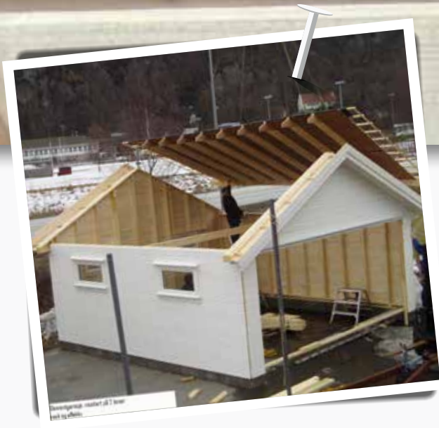
Garasje Vegg og takelementer
