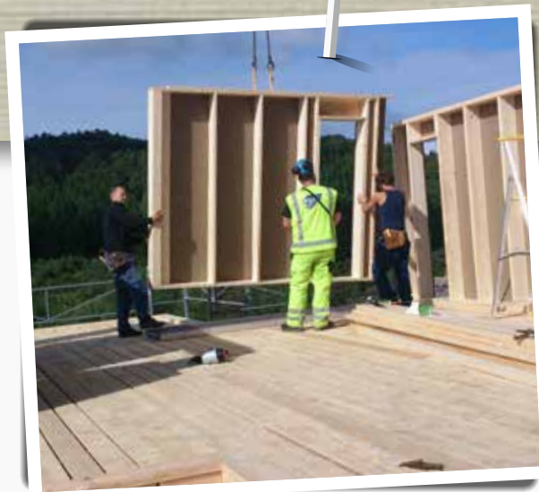
Elementbygg montasje
